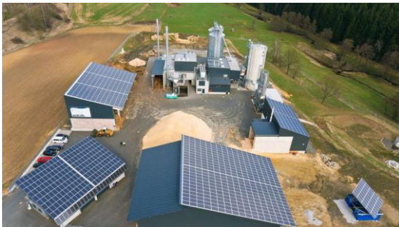
Bioenergie- und Windenergieanlage bei Wunsiedel. Fotos: SWW Wunsiedel GmbH
