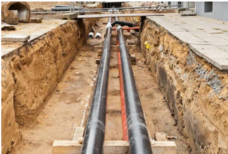
Fernwärmerohre in einer Baugrube. Foto: Fotolia fefufoto
