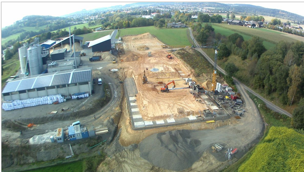
Drohnenaufnahme von den Bauvorbereitungen in Wunsiedel.
